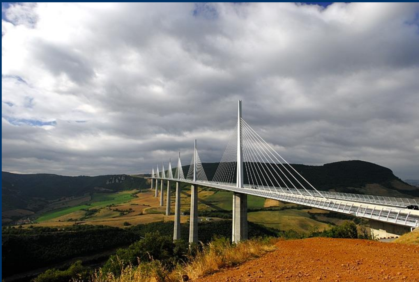
Viaduc de Millau
